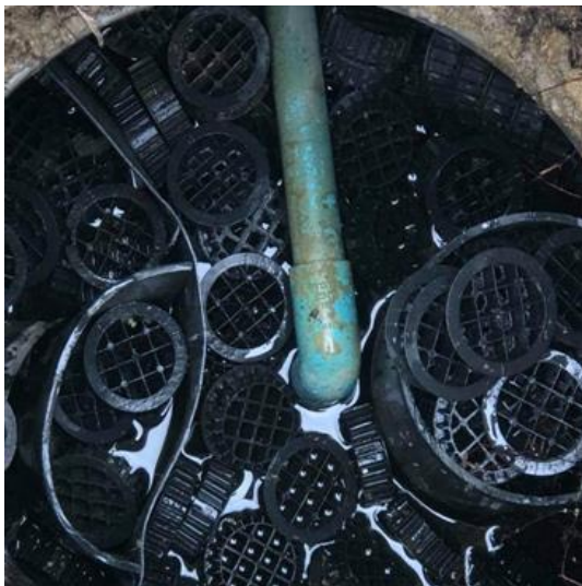
3. ตรวจสอบสภาพลูกมีเดียกักของเสียในบ่อบำบัดน้ำเสีย
